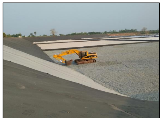
Figure 1 : vue du talus
